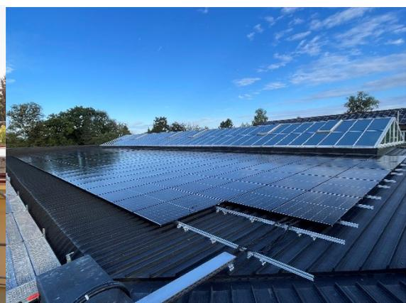
Abb. 15: Aufbau PV-Anlage Pestalozzi Grundschule CO
